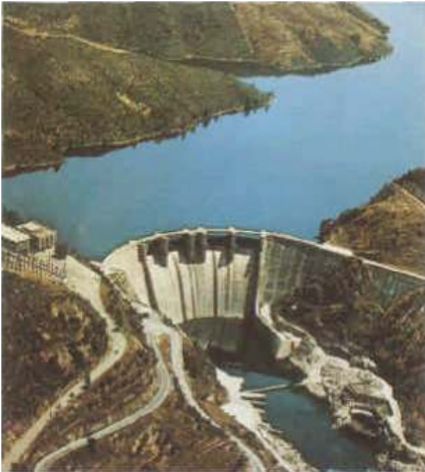
Fig. 9. Aproveitamento hidroeléctrico de Bemposta
