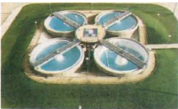
Fig. 11. Estação de tratamento de água de abastecimento
